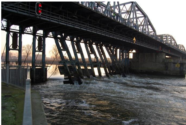
Een schip is in dichte mist dwars door de stuw gevaren. Stuwstukken zitten niet meer op hun plek en water kan vrij doorstromen. Hierdoor daalt het waterpeil tussen Sambeek en Grave met drie meter.
