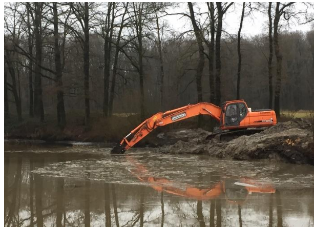
Met een kraan is anderhalve meter bodem afgegraven over een breedte van zo'n dertig meter.
